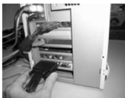
Рис. 2-2 Монтаж интерфейсного кабеля
